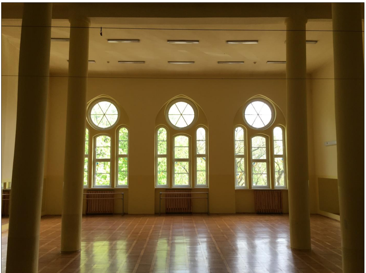
Rys. 3 Zdjęcie z widokiem na ścianę tylną Auli
